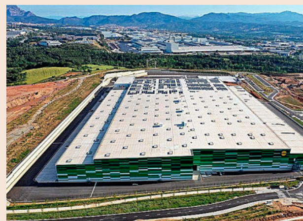
Vista aérea del nuevo centro logístico de Lidl en Martorell.
